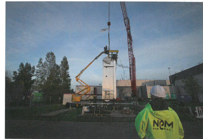
Einbau des Hochdruckdampfkessels in die Verbrennungsanlage.
