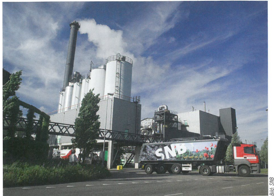
Nach der Modernisierung wird die Klärschlammverbrennungsanlage mehr Strom, als zur Deckung ihres Bedarfs benötigt wird, produzieren können.
