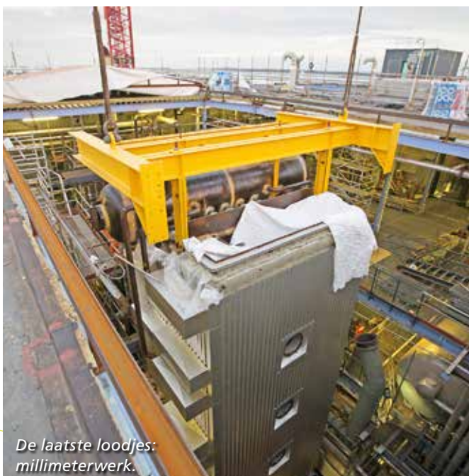
De stoomketel wordt bevestigd aan de hijskraan.
