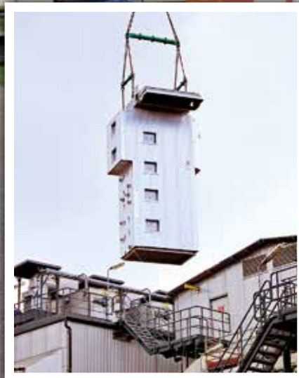
De nieuwe ecoluvo in de takels
