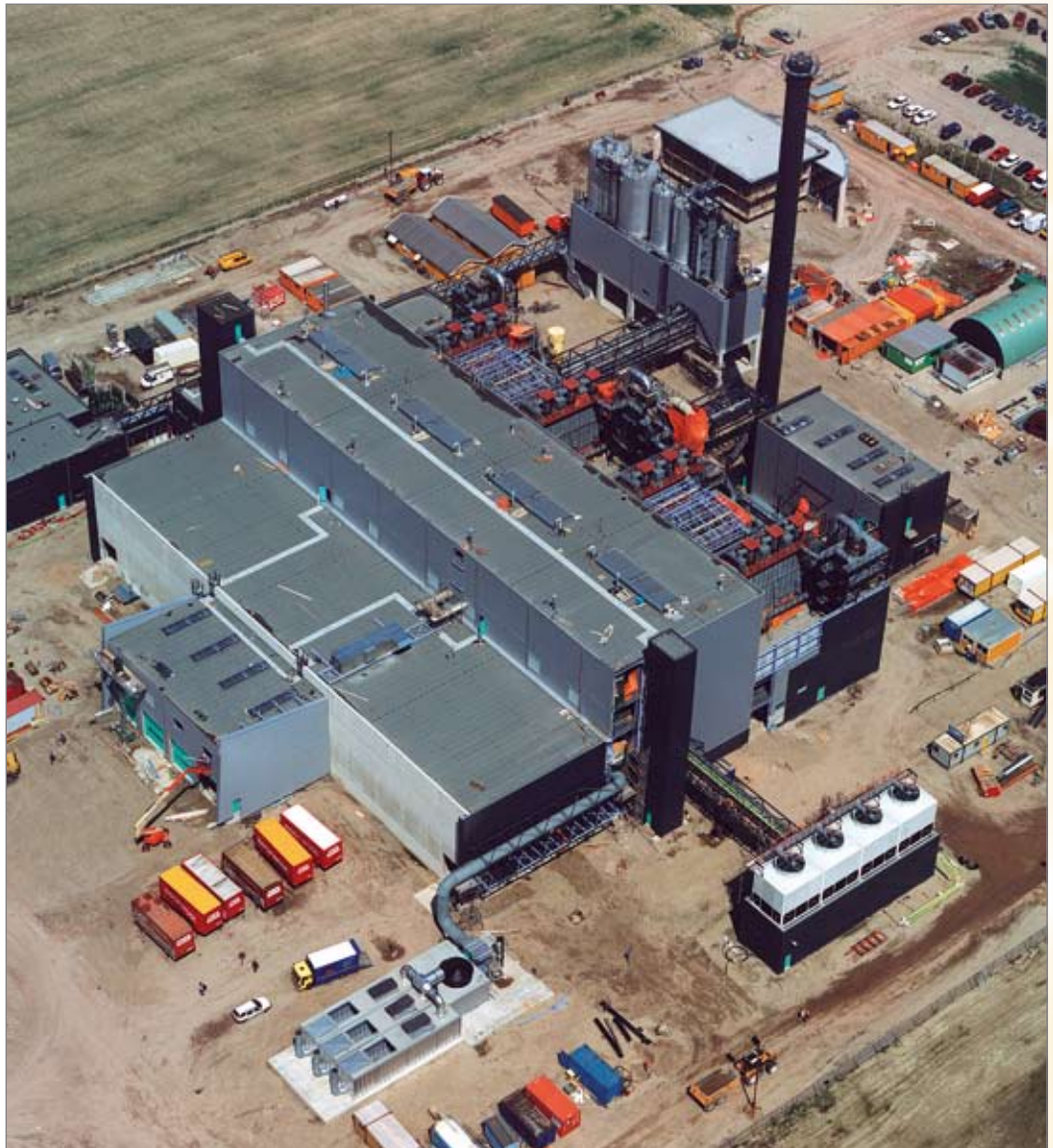
Opbouw slibverbrandingsinstallatie, voorjaar 1997
