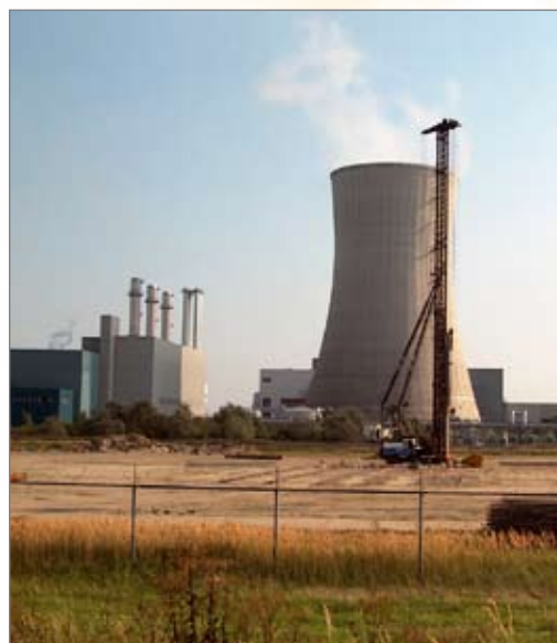
BMC is recent begonnen met de bouwwerkzaamheden voor de biomassacentrale op het terrein naast SNB
