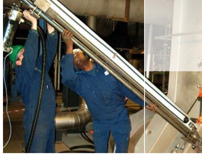
TU Delft ontwierp een speciaal gekoelde lans om de gassen af te zuigen.
