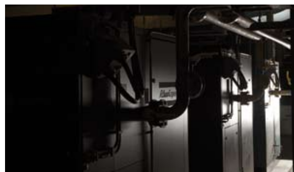
De vier nieuwe persluchtcompressoren.
