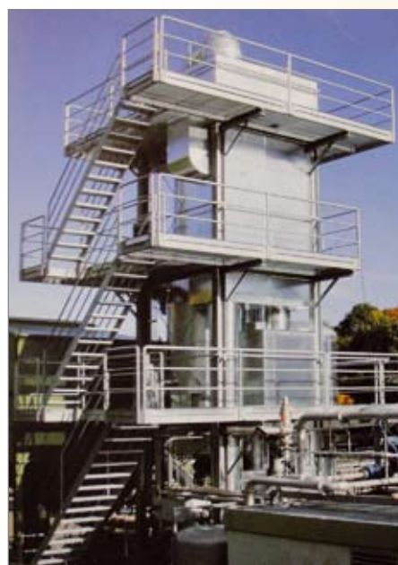
Vergassingsinstallatie RWZI in Balingen (Duitsland)
