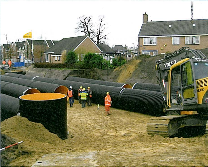
Afkoppelen in Leersum in 2009: de aanleg van een grote infiltratieverzamelleiding.
