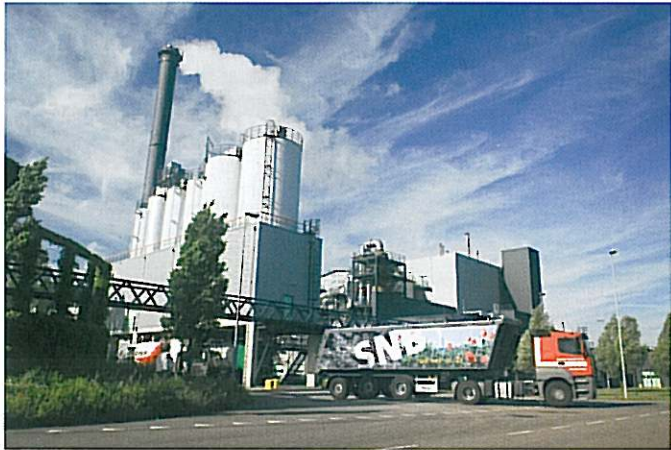
SNB heeft in Moerdijk een installatie met vier verbrandingslijnen voor rioolslib. Dagelijkse aanvoer van 50 vrachtwagens slib uit rioolwaterzuiveringsinstallaties
